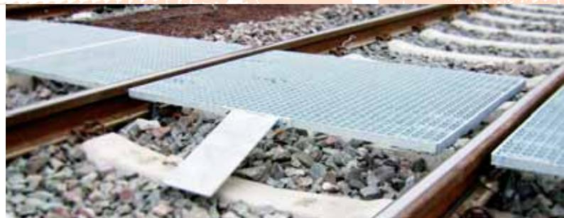
Dort, wo früher ein Weg aus Holzbohlen über Schienenanlagen führte, verbauen wir heute stabile Überwege aus speziell für Gleisanlagen patentierten Bahnrosten. Die TS-Spezialroste für die Überwege sind in den Materialien Stahl, Edelstahl und GFK erhältlich. Sie besitzen eine rutschhemmende Oberfläche, die auch im Winter bei Eis und Schnee sicher genutzt werden kann.
